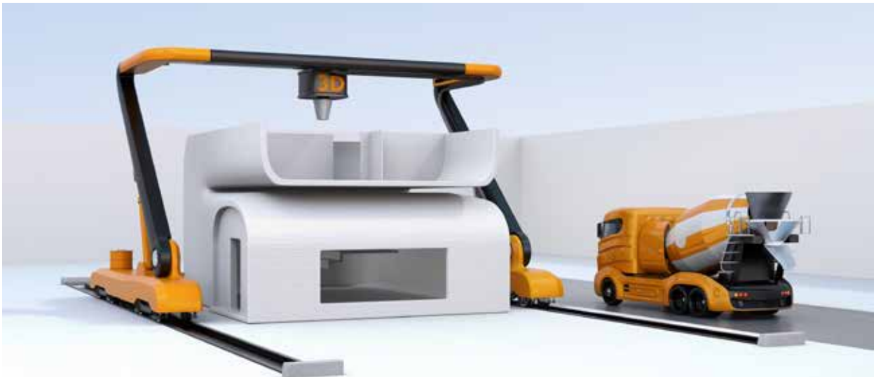
رسم توضيحي لطريقة البناء بتقنيات الطباعة ثلاثية الأبعاد
